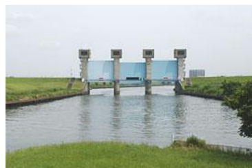
写真② 赤羽岩淵 青水門
